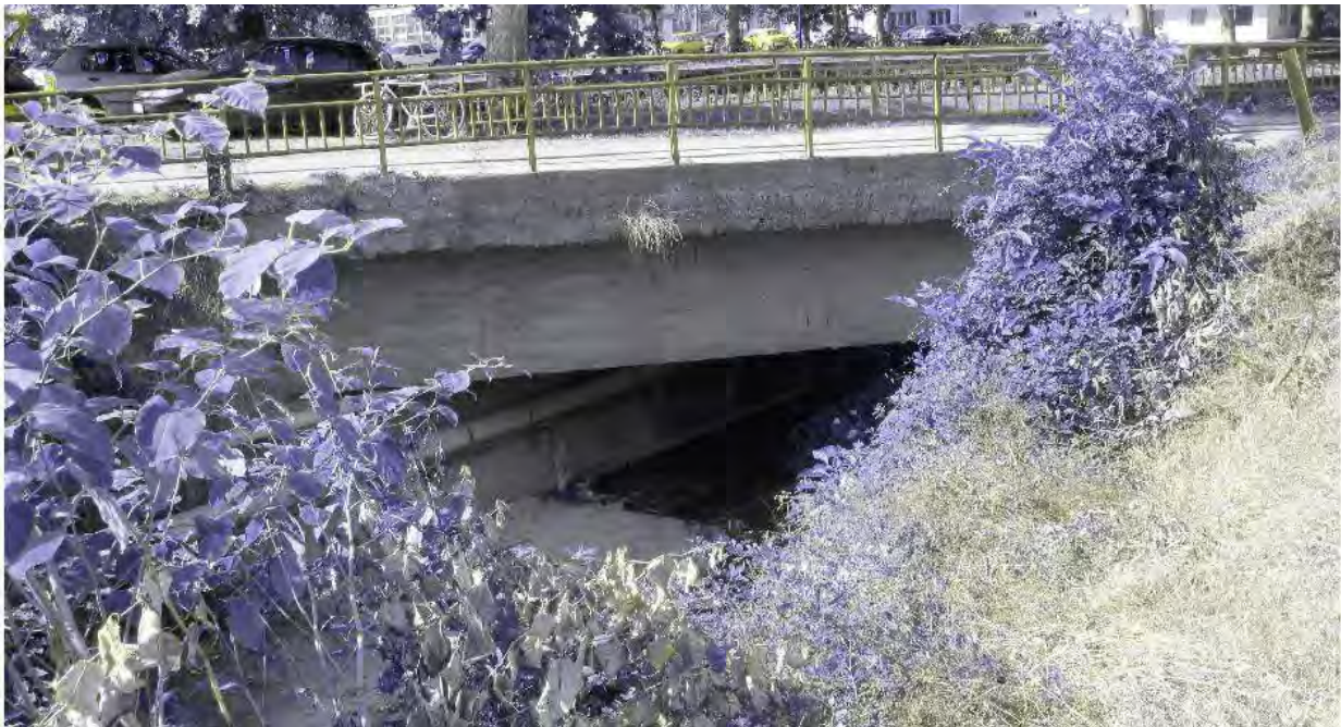
Слика 9. Лупњача, пропуст ID:RPMLu5 (недовољан протицајни профил мостовског пропуста)
